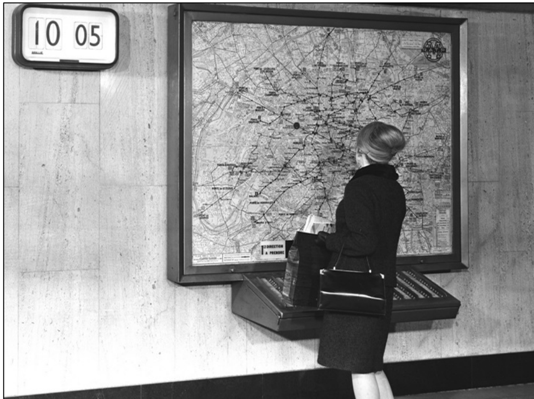
Figure 3 : Exemple d'un panneau indicateur lumineux d'itinéraires (PILI) dans une station de métro parisienne. 115
